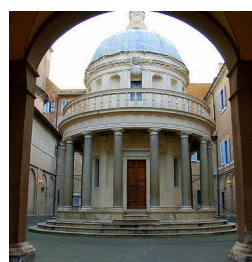
Le Tempietto de l'église San Pietro In Montorio de l'architecte Bramante (1502). ITALIE
