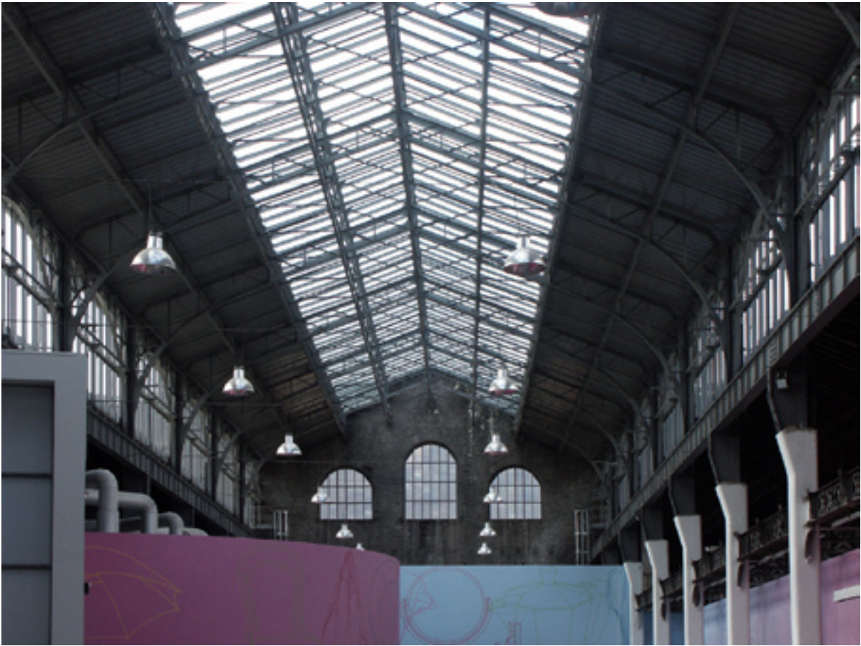
Le Magasin : charpente démontée de l'exposition universelle de Paris puis remontée à Grenoble.
