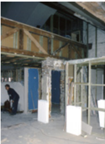
Utilisation des solives démontées lors de l’ouverture de l’espace du grenier pour construire une poutre-treillis, Liège.
