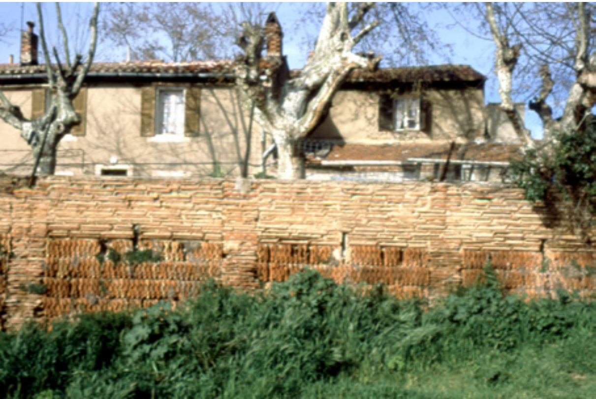
Utilisation d’anciennes tuiles pour construire un mur de clôture, Marseille.
