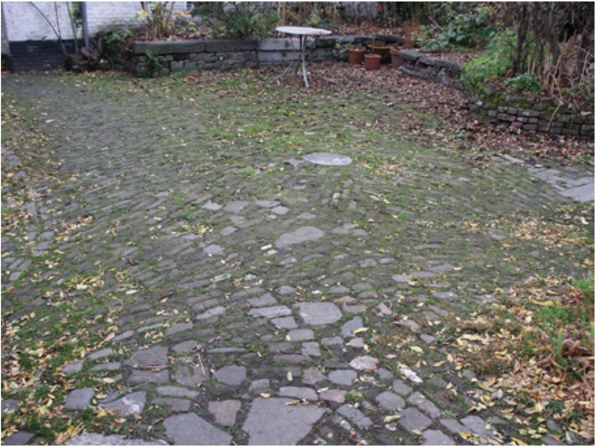
Pierres et briques de réemploi formant un revêtement de sol perméable et démontable (joint sec en sable), cour publique dans l'impasse de la Vignette, Liège (Be).
